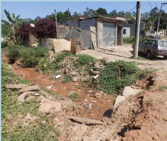
Lançamento de esgotos em córregos – Jardim Canaã/ Itaquaquetuba/SP.
