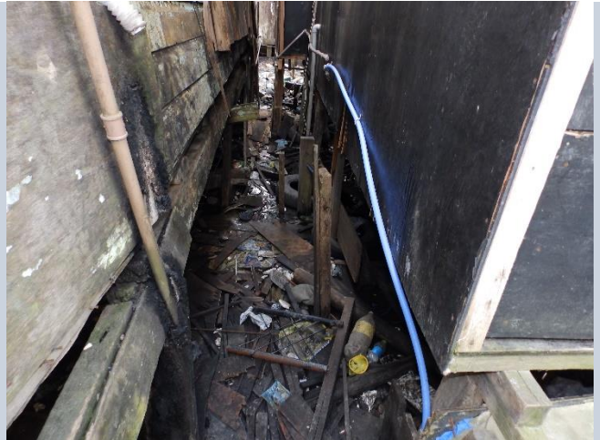
Ligações de água através de mangueiras e tubulações em Santa Cruz dos Navegantes/SP.
