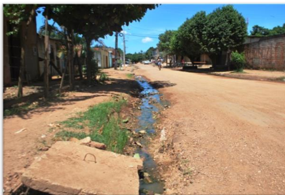
Inexistência de esgotamento sanitário no município de Ariquemes (RO).
